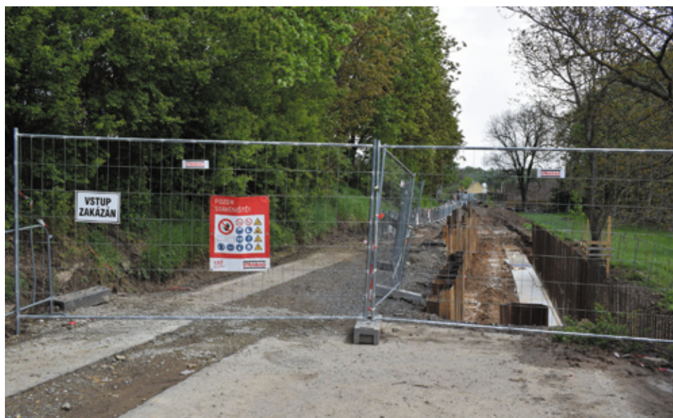
Uzávěra silnice do Úholiček a stavba nové podpěrné zdi (foto Tomáš Hejna)
