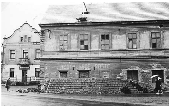
Budova kina při rekonstrukci v roce 1965 (čp. 129)
