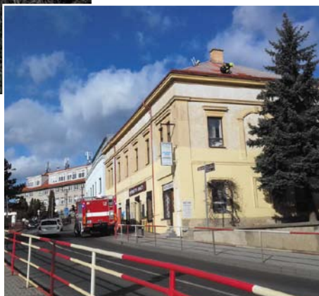
Zásah hasičů na střeše domu čp. 130
