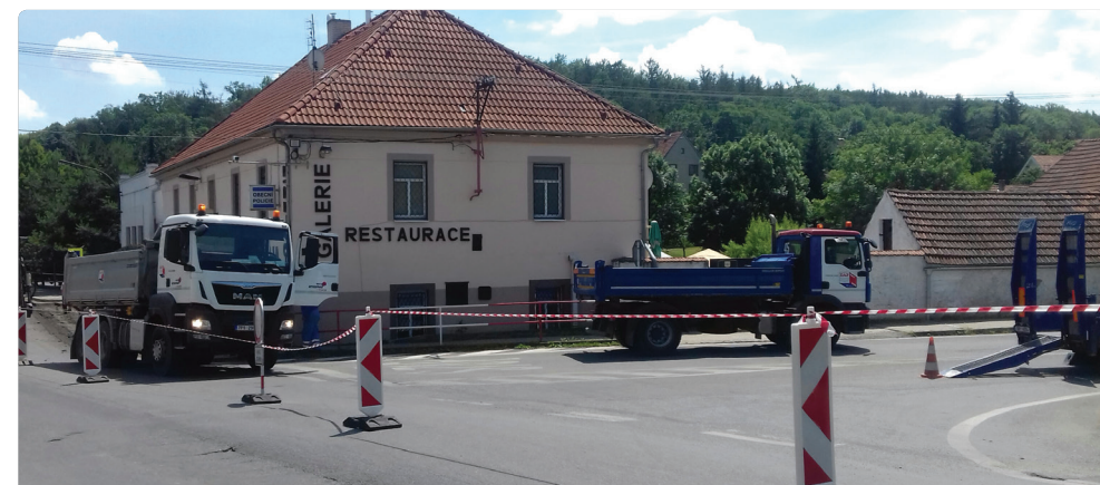
Výstavba světelné křižovatky začala 16. června. Plánovaný termín dokončení je 17. září 2019
