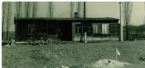
Dřevěné kabiny na novém hřišti, šedesátá léta 20. století
