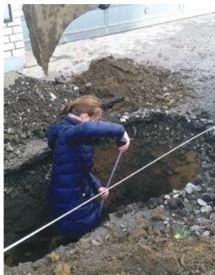
Referent stavebního odboru musí při výkonu své práce vstoupit i do výkopu
