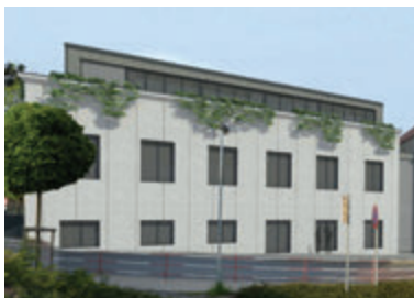
V říjnu začínáme !!! - Polyfunkční dům pro základní školu
