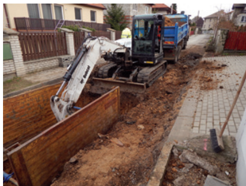
Obec loni uskutečnila opravu komunikace v ul. Pod Hajnicí, Příčná, Souběžná za celkovou cenu 10,5 mil. Kč.
