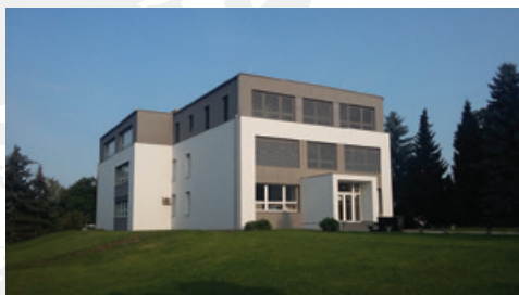
Budova II. stupně ZŠ se rozrostla o pět tříd se sociálním zázemím, požární schodiště, zrekonstruované vnitřní schodiště a jídelnu.
