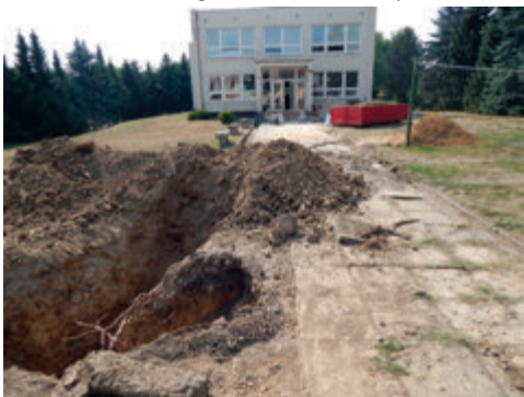
Koncem června se s opravami školní budovy začalo
