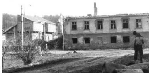
Kohoutův statek před demolicí v roce 1975
