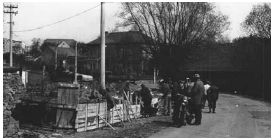
Prostranství, kde je dnes autobusová točka a budova bývalé samoobsluhy, bylo poznamenáno demoliční činností. Snímek z r. 1972 zachycuje členy místního svazu myslivců při brigádě na terénních úpravách
