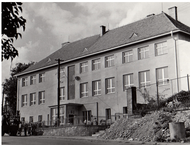
Budova Základní školy v září 1961
